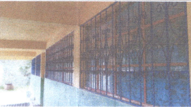
Foto 3: Sustrución de balcones de metal parte frontal modulo 1.
