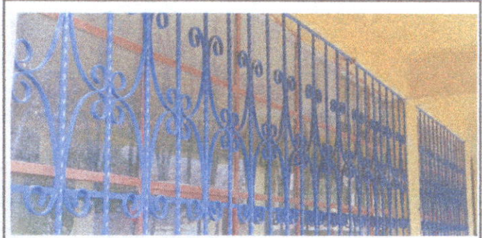
Foto 4: Sustrución de balcones de metal parte frontal modulo 2.
