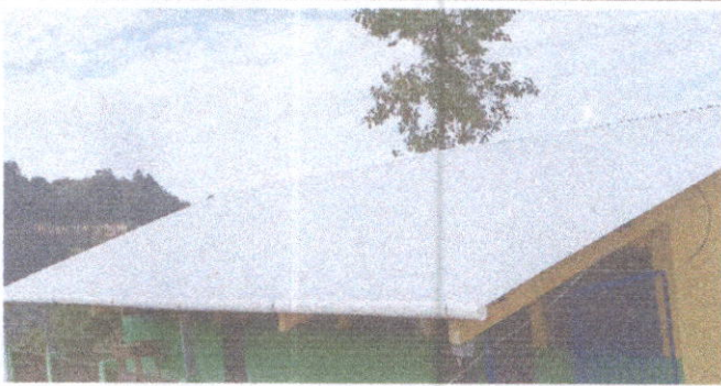
Foto 1: Sustrución de lamina por lamina troquelada aluzinc calibre 26 modulo 1.
