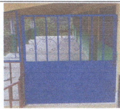
Foto 6: Sustrución de puerta de metal entrada principal modulo 2.
