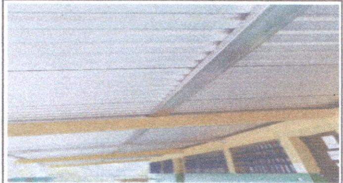
Foto 2: Sustrución de estructura de soporte de madera por metal modulo 2.
